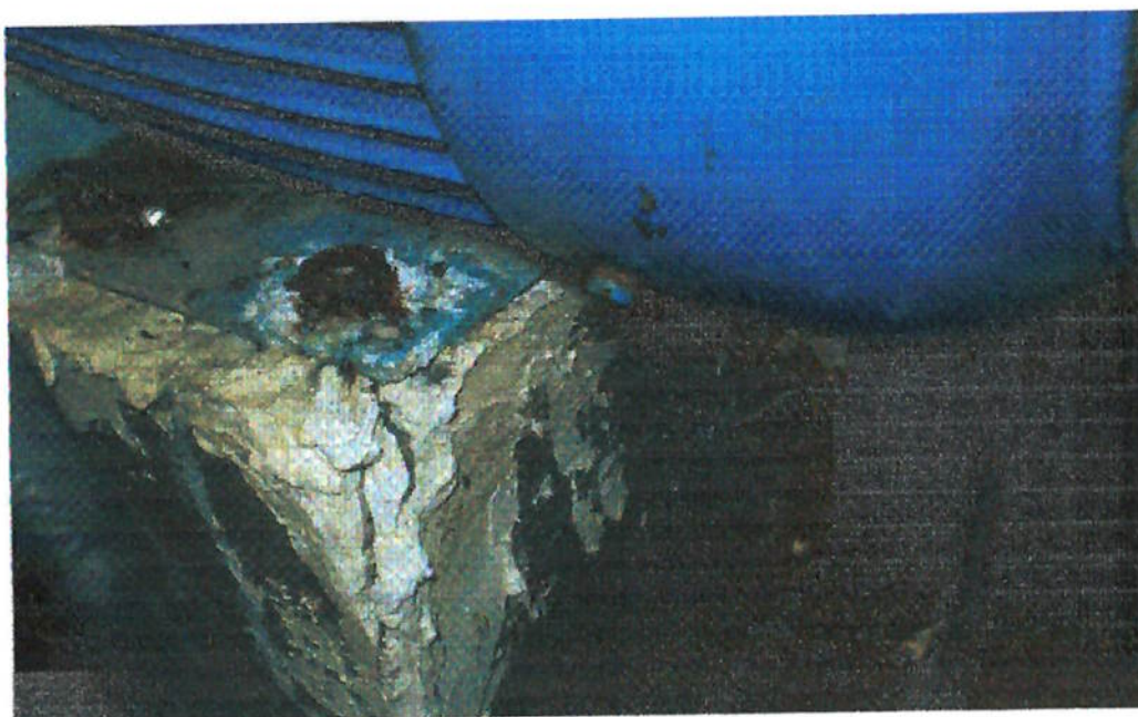
Figura 4.4.2.6.1.2: Esquema do calço de borracha para redução de vibração nas instalações do “Badu Jet”.
